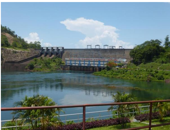
【ナムグムダムの堤体を下流から眺める】
