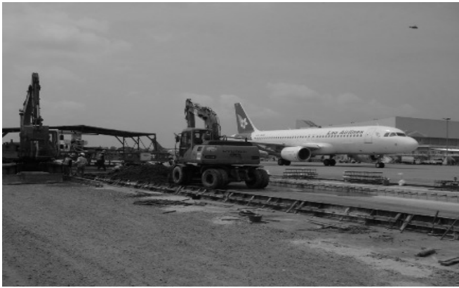
建設中のワットタイ国際空港
